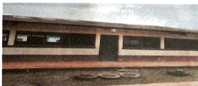
Cambio de lamina y puerta.
