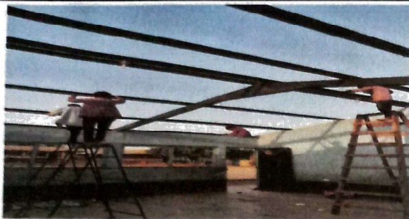
Limpieza y mantenimiento de costaneras
