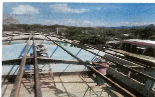
Preparacion de costaneras para colocacion de techo.
