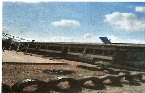
Cambio de techo.
