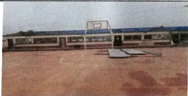
Inicio de colocacion de techo.
